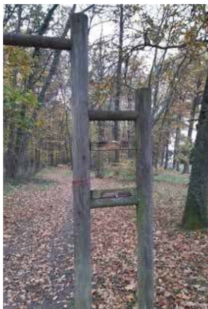
Dégradation du parcours sportif
