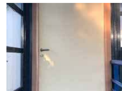
Nouvelle porte de séparation entre le stockage et la cantine des Dîmerons
