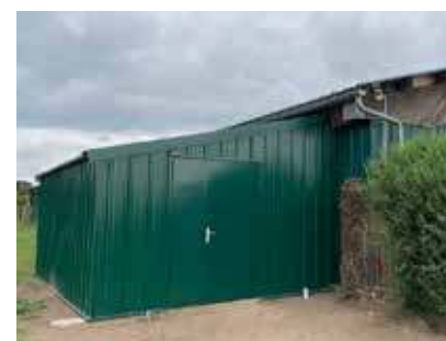
Local pour le rangement du matériel de football au Stade du Servois
