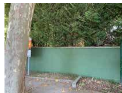
Remise en état du muret, rue du Pont Saint-Jean, près du collège
