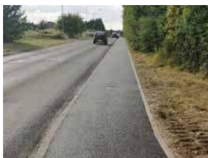
Enrobage du trottoir reliant la rue du Four à Chaux au stade du Servois.
