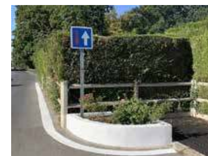
Rue du Pont Saint-Jean : restauration de bacs à fleurs au rétrécissement de voie
