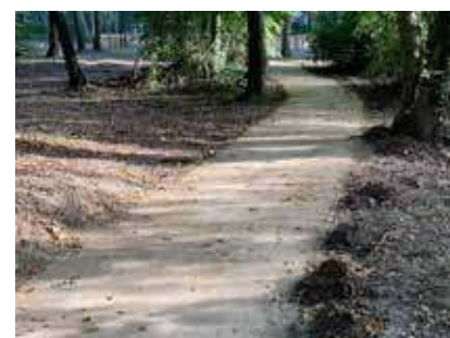
City stade : construction d'un chemin d'accès côté sud en calcaire compacté
