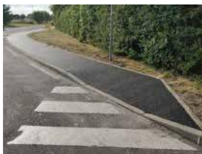
Enrobage du trottoir reliant la rue du Four à Chaux au stade du Servois.
