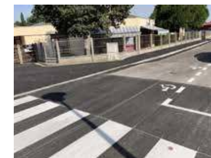
Trottoir et stationnement pour personnes à mobilité réduite à l'École des Dimerons
