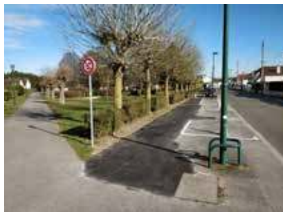
Réparation du trottoir, place de la Glorie
