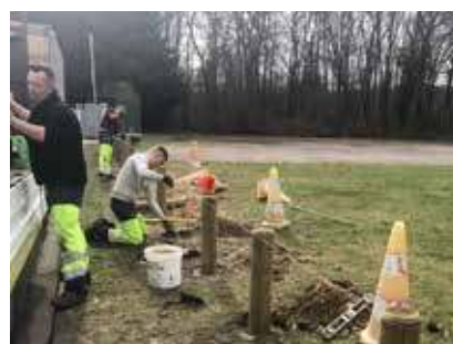
Protection de la zone face à la caserne des pompiers contre les installations sauvages
