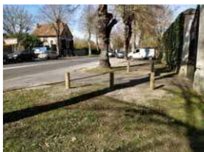
Implantation de potelets en bois rue de Paris nord
