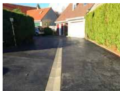
Rénovation de l'allée des Mûres
