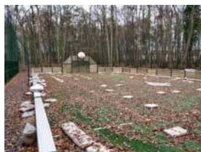
City stade en cours de finalisation rue du Pont Saint-Jean
