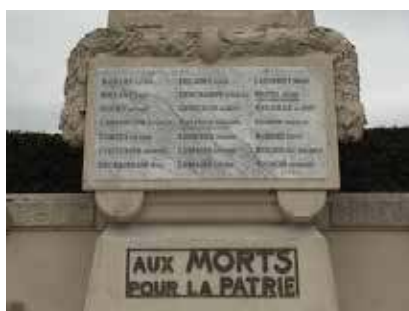
Rénovation du monument aux morts et installation d'une nouvelle plaque
