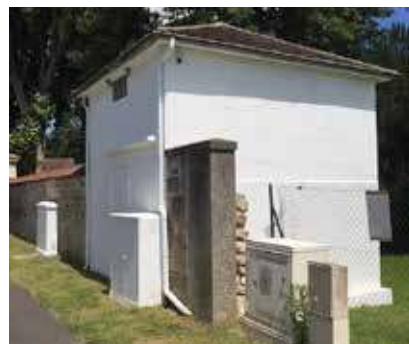
Peinture du poste électrique
