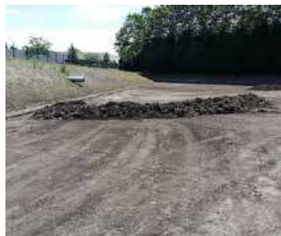
Entretien du bassin de retenue à côté de l'École du Bois de Chênes
