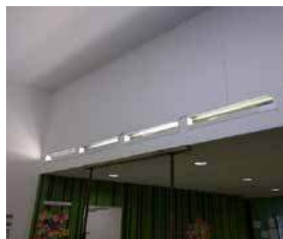
Réparation du plafond de l'école élémentaire du Bois de Chênes
