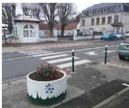
Potelets anti-stationnement rue de Paris
