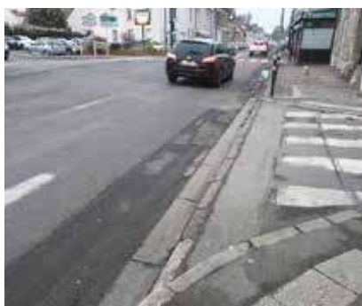
Bouchage du trou à l'intersection de la rue du Vieux Château et de la rue de Paris
